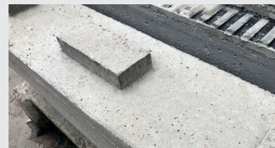
Zadrževalni bloki iz betona, ojačanega z vlakni.
